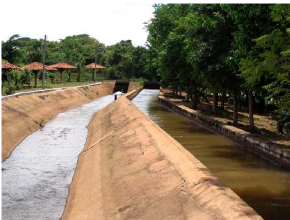
Figura 7. Canais desviados do Rio para abastecer as turbinas da Usina (VOLLET, 2006).
